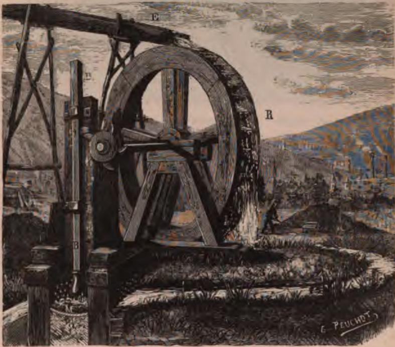
Fig. 159. — Préparation des minerais. — Bocardage.
